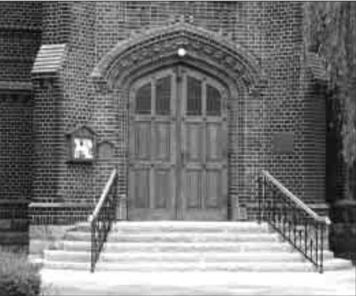
▲ Teprve nedávno byly rekonstruovány schody vrbeckého kostela, které dodaly vstupu do chrámu patřičnou důstojnost
