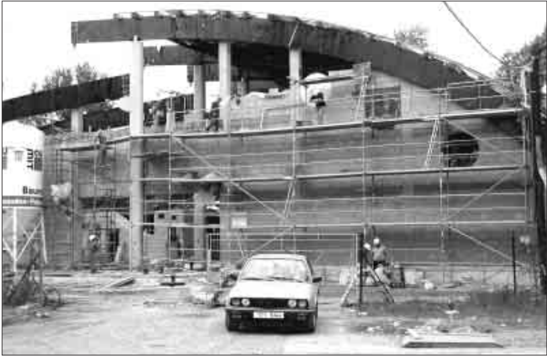
▲ Bazén - sledovaný objekt č. 1 - rychle pokračuje v hrubé stavbě
