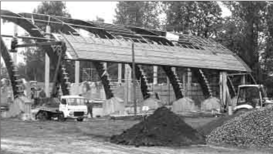
▲ Konstrukce klenuté střechy bazénu, jehož výstavba úspěšně pokračuje, dává tušit rozměry celé stavby. Snímek byl pořízen 13. května 2004. Bazén by měl být otevřen v prosinci.
