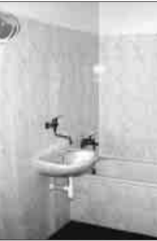
▲ Pohled do koupelny jednoho z bytů v nedávno opraveném domě na ul. Čs. armády
