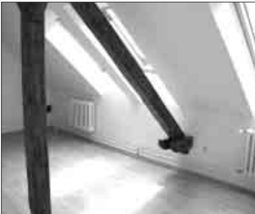
▲ Rekonstruované byty v domě na ul. Čs. armády č. 689 jsou zajímavé velkými lodžemi, v podkrovních bytech různými úrovněmi podlah a původním trámovím v interiéru.
