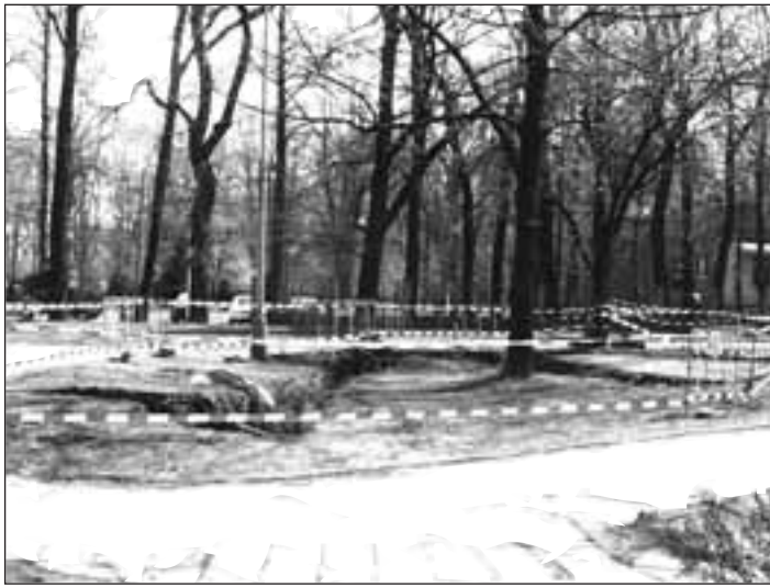
▲ Na Šunychelské ulici v současné době probíhá rekonstrukce plynovodu. Dokončení se předpokládá k 30. červnu letošního roku.
