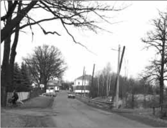
▲ V listopadu roku 2001 byla provedena oprava veřejného osvětlení na Šunychelské ulici a tím i splněn jeden z požadavků občanů Šunychlu
