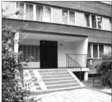
▲ Letos byly opraveny nevzhledné vchody do panelových domů
