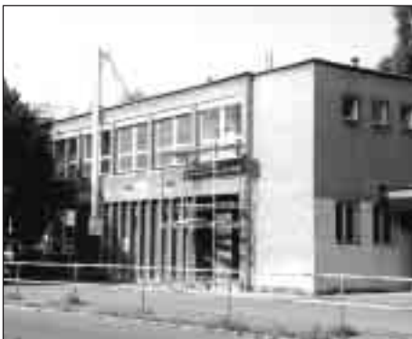
▲ Díky osmimiliónové dotaci ze státního rozpočtu byla během prázdnin prováděna rozsáhlá rekonstrukce základní školy na ulici Čs. armády. Práce byly náročné a poněkud se protáhly, takže nový školní rok zde bude zahájen až v pondělí 9. září 2002.
