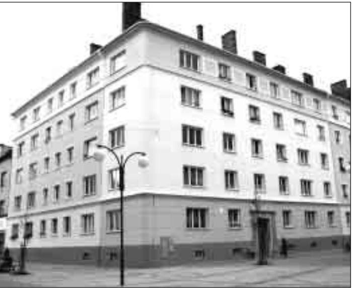
▲ Na křižovatce tř. Dr. E. Beneše a Poděbradovy září další nová fasáda
