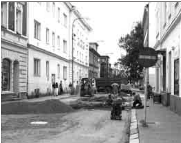
▲ V těchto dnech byla dokončena rekonstrukce kanalizace Studentské ulice, kterou prováděli pracovníci Sm Vak
