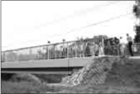
▲ Požadované úpravy u nového mostu v Šunychlu již byly provedeny
