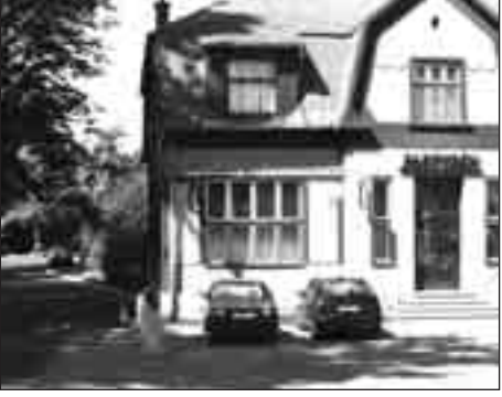
▲ Naproti restauraci Partyzán v Záblatí by chtěli mít občané autobusovou čekárnu
