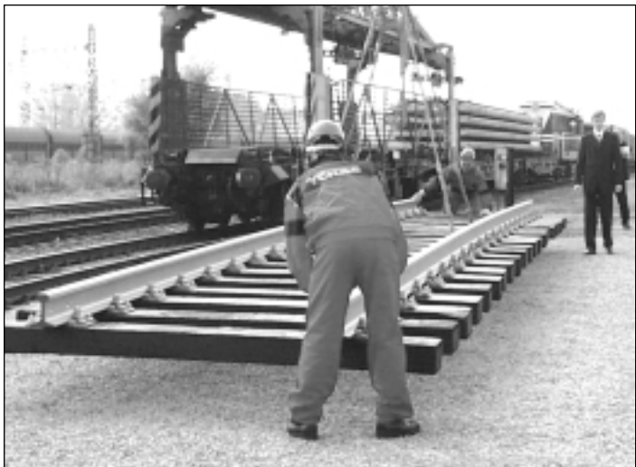
▲ Takto vypadalo 10. října položení základního stříbrného dílu budoucí širokorozchodné tratě ve Vrbici
