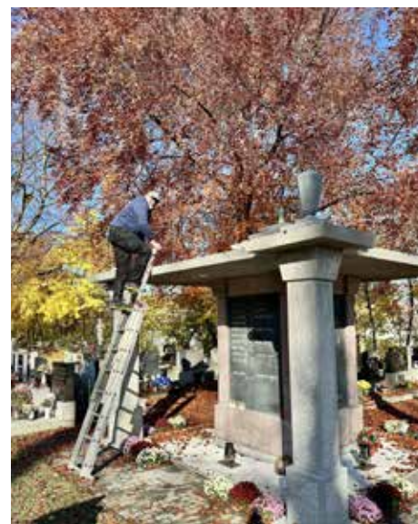
Foto z realizace opravy
