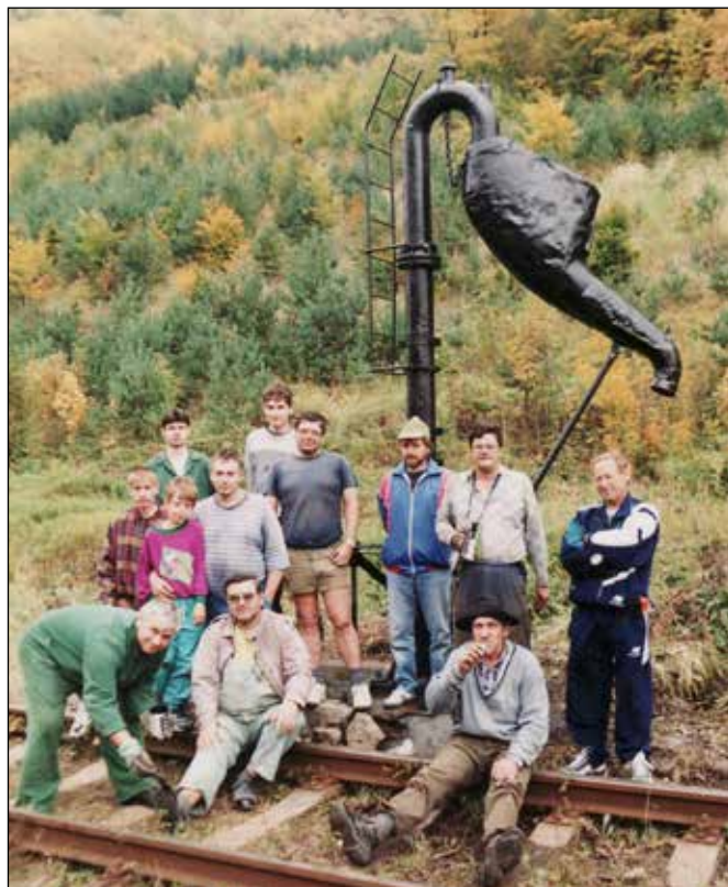
Oprava vodního jeřábu v Klokočově v roce 2000.
