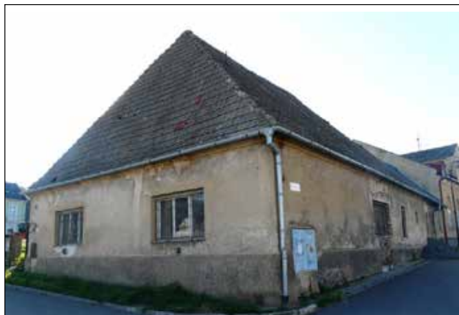
Katovna před rekonstrukcí v roce 2012
