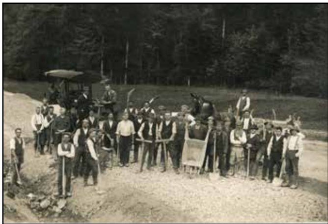
Stavba silnice z Jakubčovic do Dobešova.
