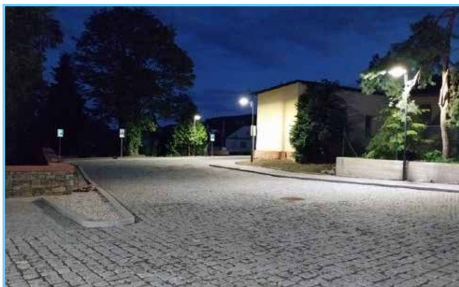
Součástí stavby je nové veřejné osvětlení a obnova zámecké zdi z lomového kamene.
