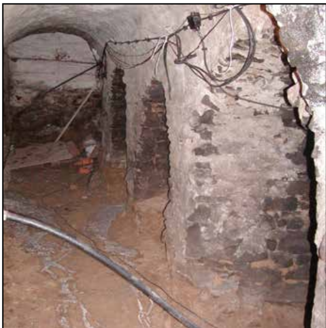
Zaklenuté výklenky směrem ven ze sklepa v domě č. p. 21
