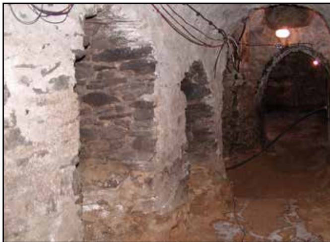
Výklenky chodbicového sklepa v domě č. p. 21
