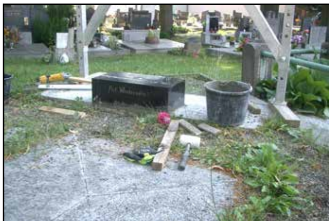
Usazení spodního dílu a přípravné práce před montáží jednotlivých dílů náhrobku. Foto: Pavel Kašpar st. – 2022
