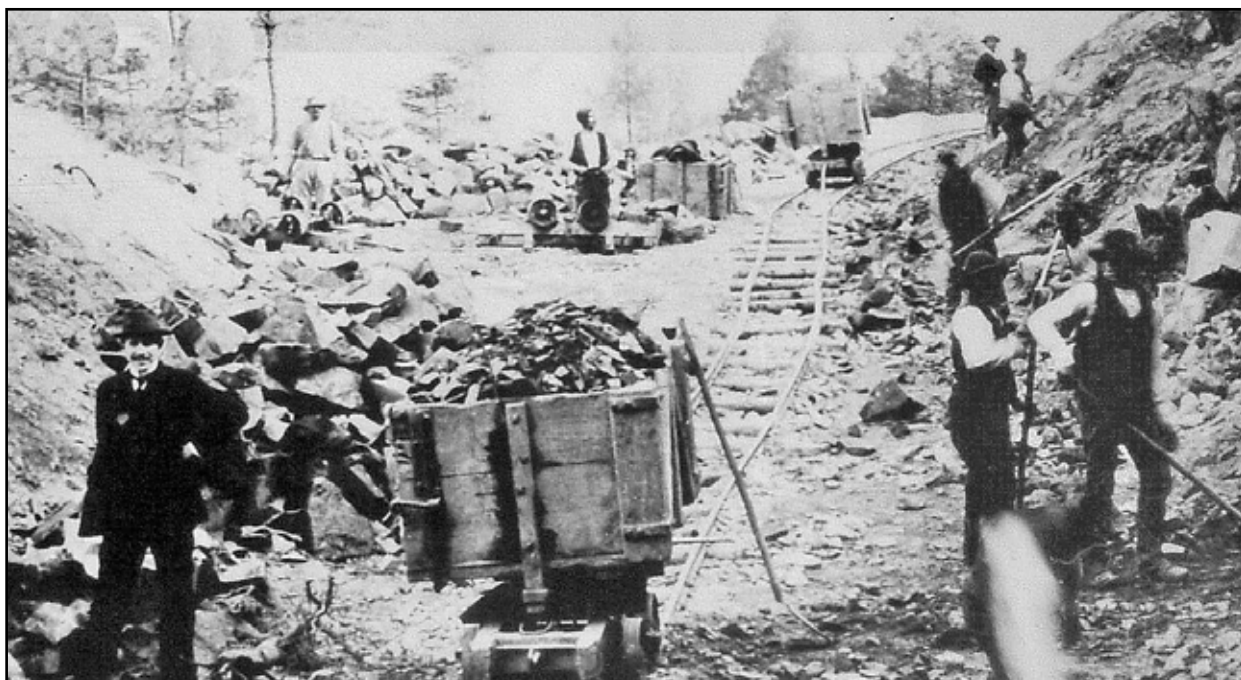
Zaměstnanci (barabové) firmy Alois Vanzin při stavbě jedné ze silnic v okolí Odr – jedná se zřejmě o úsek mezi třetí a čtvrtou serpentinou horské silnice Odr – Dobešov. Archiv Muzejního spolku Rolleder, Odr, o. p. s.
