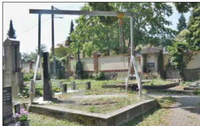
Konstrukce montážní rampy s kladkou firmy Kamenictví Jakubík Odry pro instalaci trojdílného náhrobku, věnovaného rodině Vanzin na jejich vyprázdněném hrobovém místě. Foto: Pavel Kašpar st. – 2022
