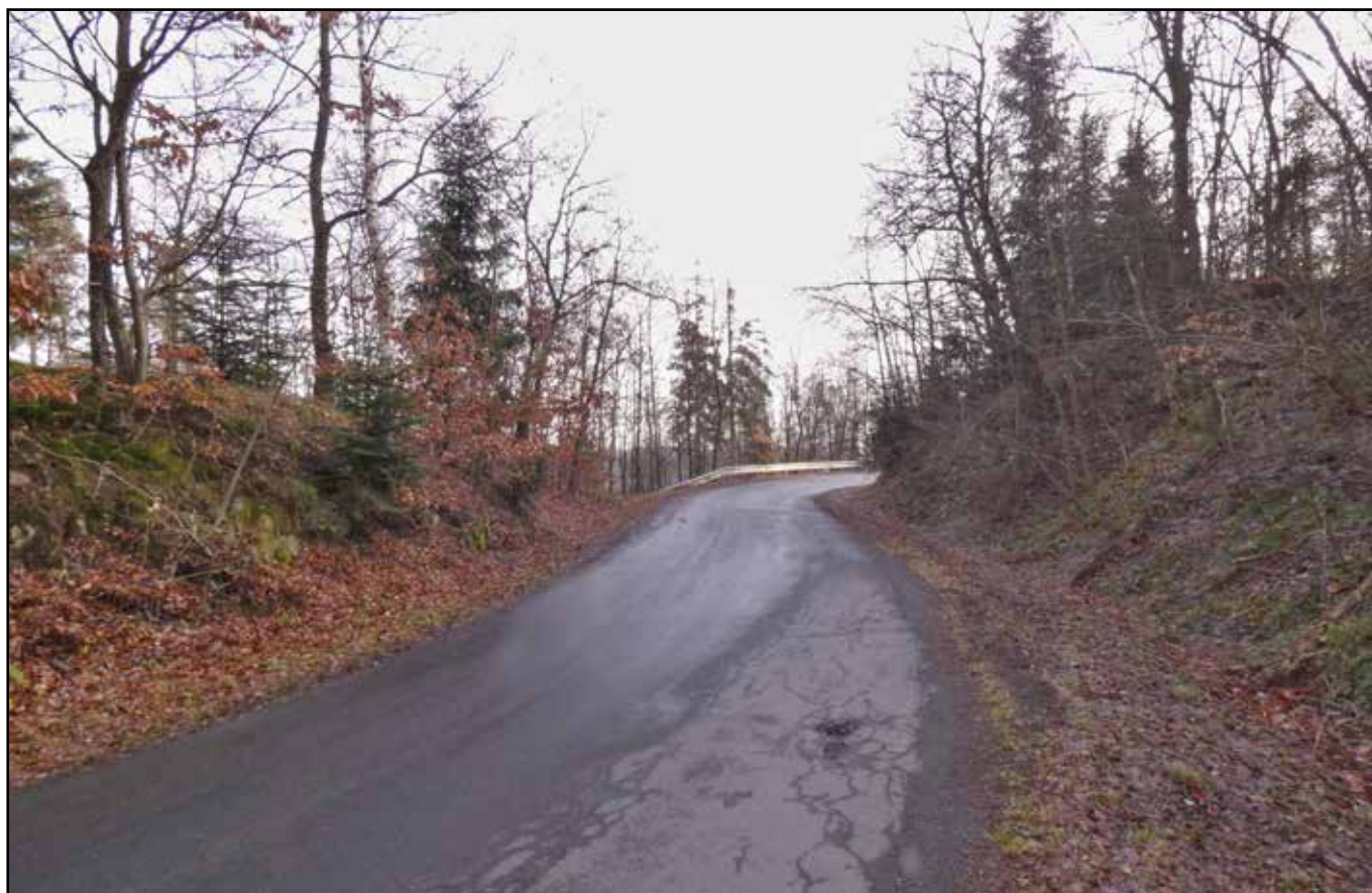
Úsek mezi třetí a čtvrtou serpentinou horské silnice Odry – Dobešov dnes. Vpravo se nacházejí dva malé lomy, jejichž kámen mohl sloužit ke zpevnění podloží čtvrté serpentiny. Foto: Jiří Kucharz – 2023
