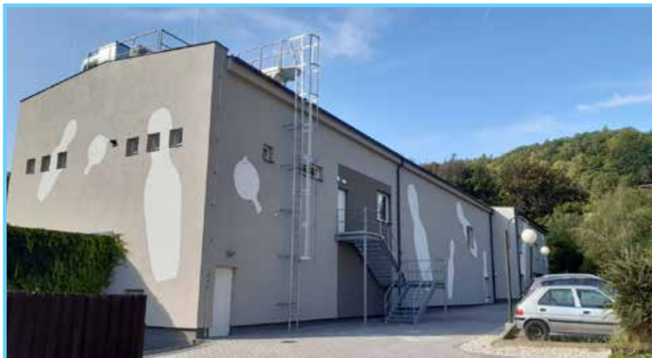
Budova byla zateplena a vyměnily se okna i dveře.
