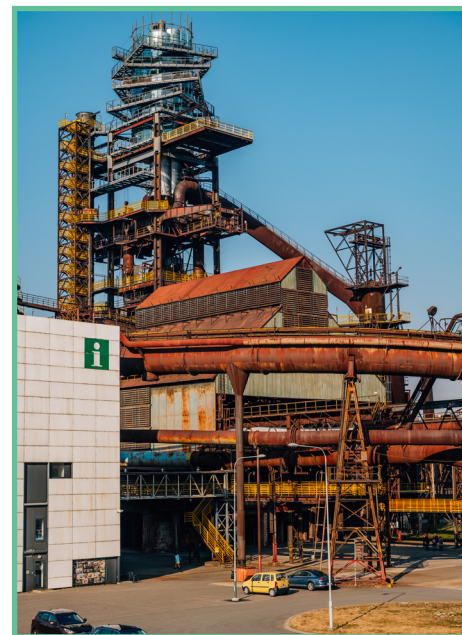
Vysoká pec č. 1 s nástavbou Bolt Tower - Ostrava
