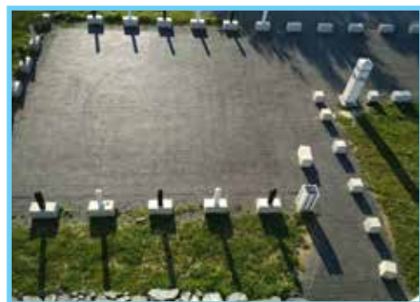
Výstavba turistické infrastruktury, Veselská rozhledna
