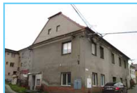
Demolice objektu, Odry
