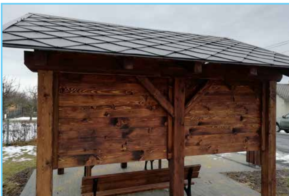
Vybudování odpočinkových altánů a dopravního značení v Odrách
