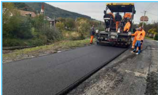
Obnova komunikací, Loučky
