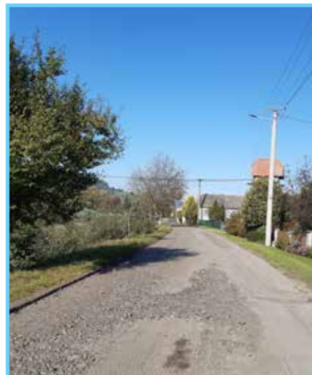
Obnova místních komunikací, Loučky
