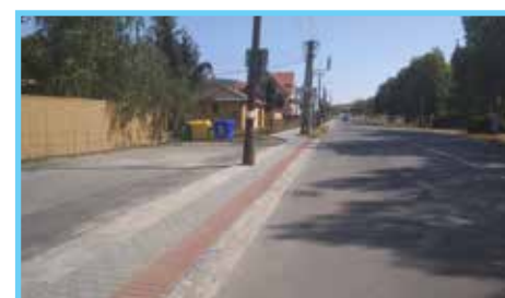
Vybudování chodníku na tř. Osvobození
