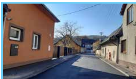
Obnova místních komunikací v Odrách
