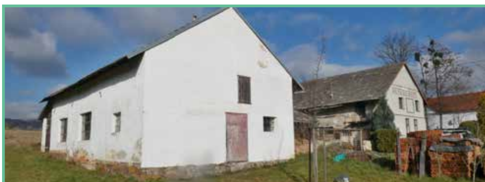
Objekt bývalé kovárny čp. 71 v Hynčicích v roce 2021.
