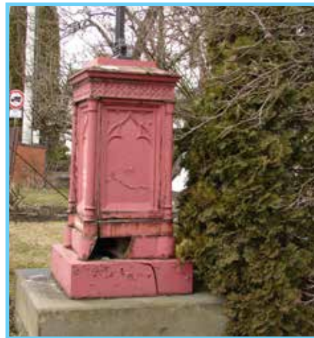
Původní stav, pohled z pravé strany
