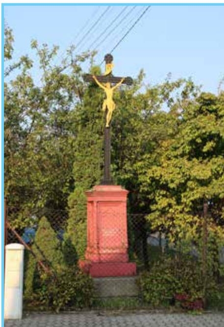
Stav před opravou
