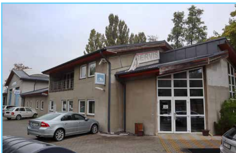
Areál bývalého autoservisu SONAS, budoucí areál technických služeb.
