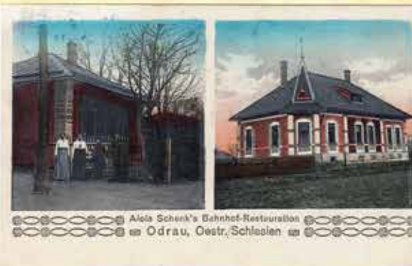
Vlevo nový objekt nádražní restaurace (čp. 442) zřejmě se členy rodiny Aloise Schenka. Vpravo jejich rodinný dům (čp. 450), který stál nedaleko - dnes pozemek Optimitu (demolice ca 1980). Archiv Muzejního spolku Rolleder
