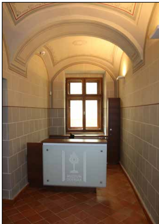
Zrekonstruovaná místnost se šablonovou výmalbou
