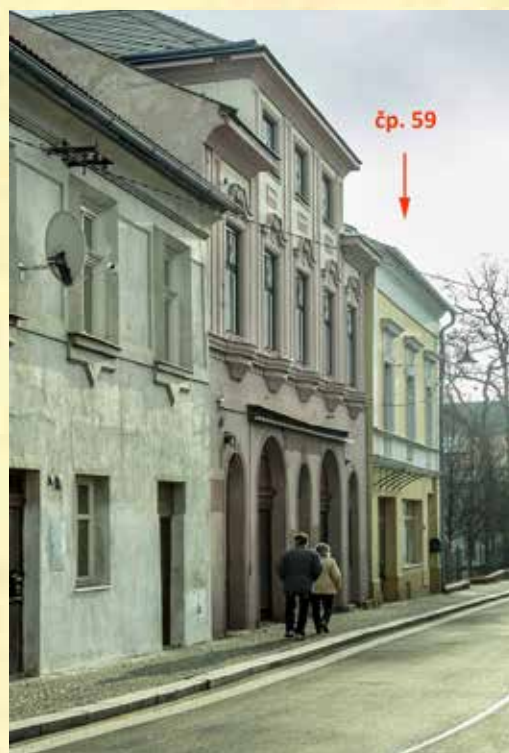
Dům č. p. 59 Foto: Jindra Kunc
