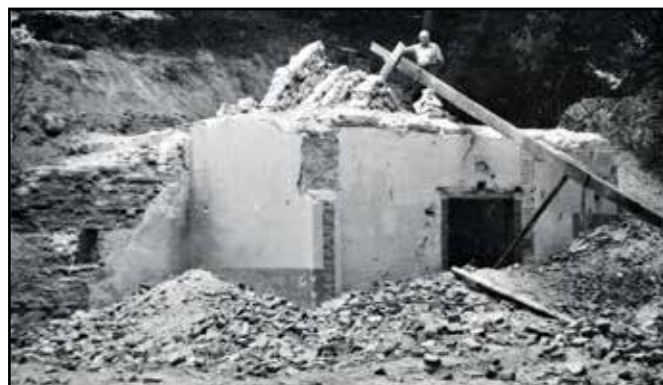
Demolice I. Skalního sklepa v roce 1952
