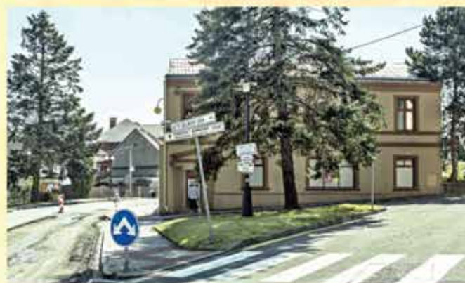
Dům č. p. 100 Foto: Jindra Kunc
