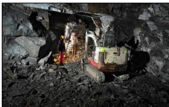
Práce na zpřístupnění Flascharova dolu
