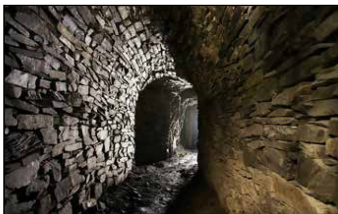
Vyskládaná chodba v místě původního větracího okna ve štole Nový Svět B
