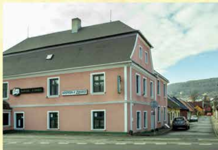
Dům č. p. 43 Foto: Jindra Kunc
