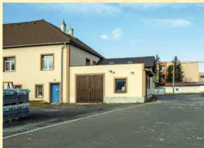
Dům č. p. 328 Foto: Jindra Kunc
