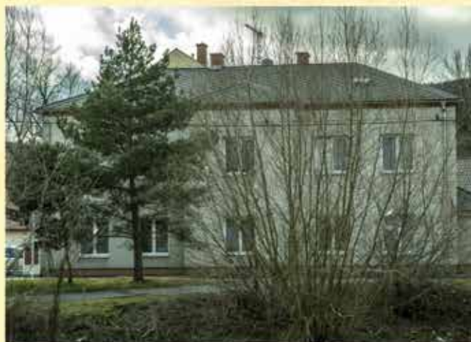
Dům č. p. 288. Foto: Jindra Kunc
