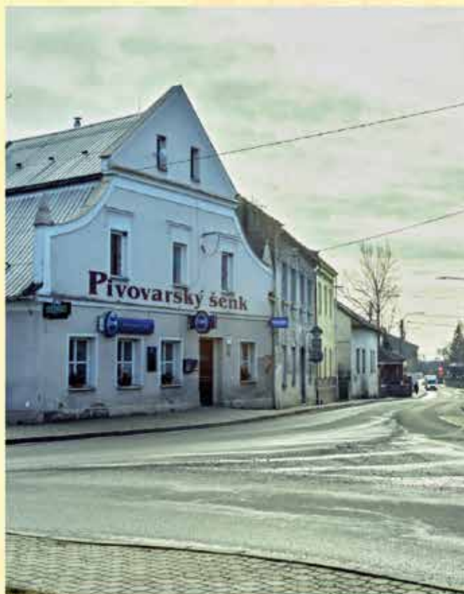
Dům č. p. 146. Foto: Jindra Kunc
