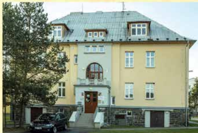
Dům č. p. 480. Foto: Jindra Kunc
