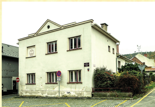
Dům č. p. 63 Foto: Jindra Kunc
