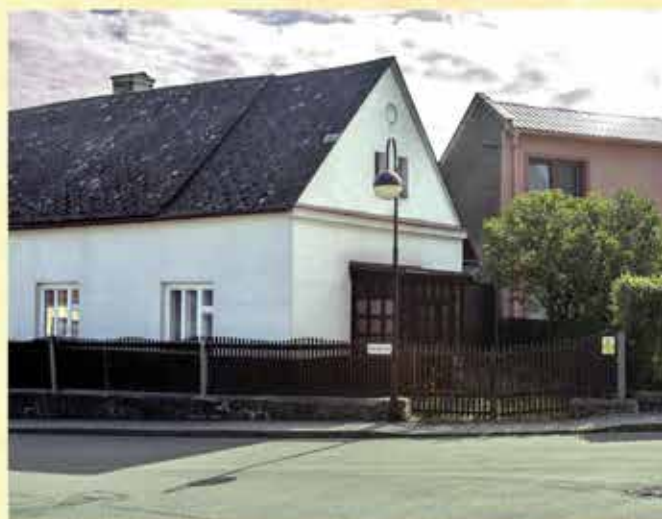
Dům č. p. 111 Foto: Jindra Kunc
