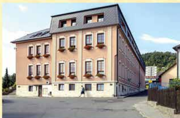
Dům č. p. 188 Foto: Jindra Kunc
