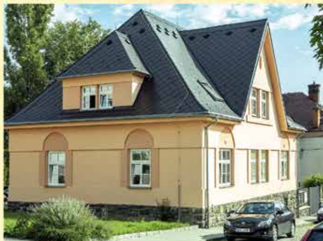
Dům č.p. 517. Foto: Jindra Kunc
