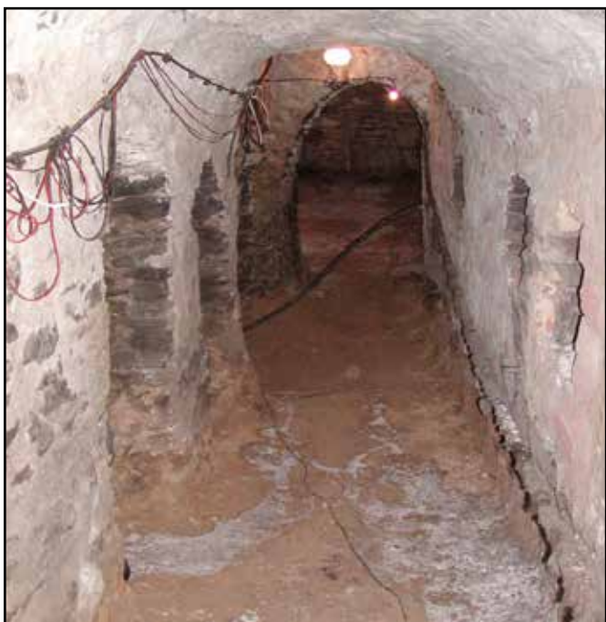
Foto č. 4 - Chodbicový sklep
