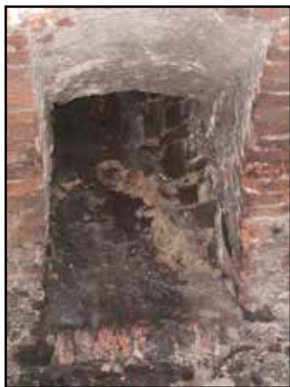
Foto č. 28 - Detail renesančního okenního záklenku
