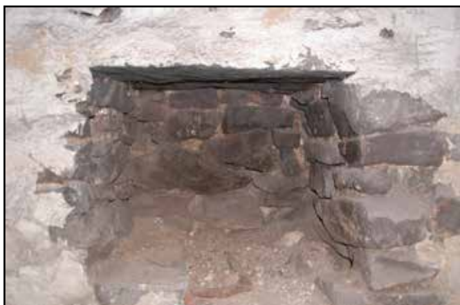
Foto č. 13 - Detail nezaklenutého výklenku
