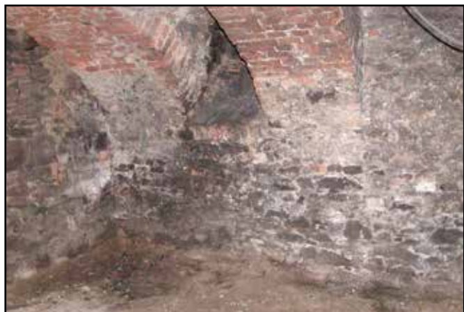
Foto č. 27 - Renesanční sklep s okenními záklenky a se zazděným únikovým otvorem
