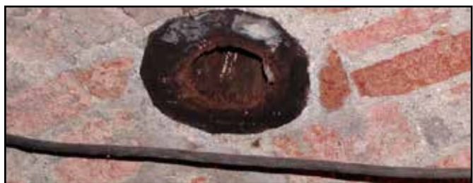
Foto č. 26 - Dřevěná roura ve vrcholu klenby renesančního sklepení
