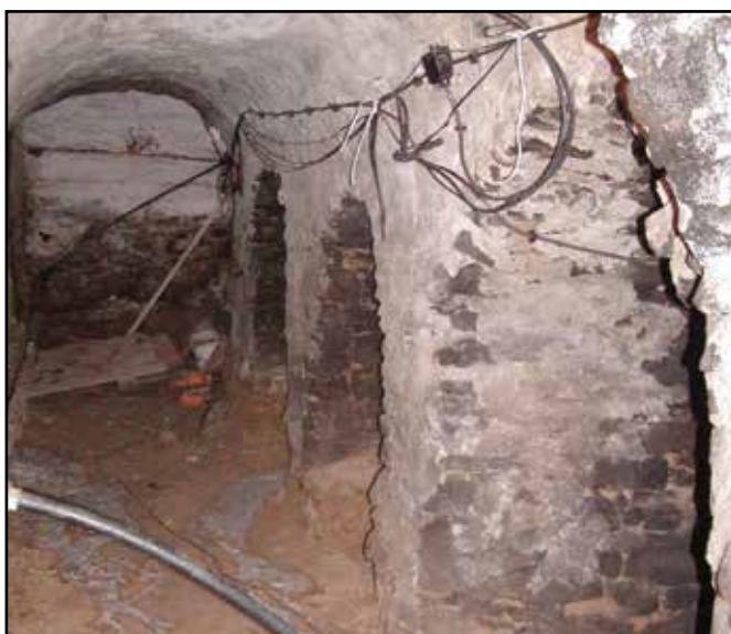
Foto č. 6 - Zaklenuté výklenky chodbicového sklepa - pohled ze sklepa ke vstupu
