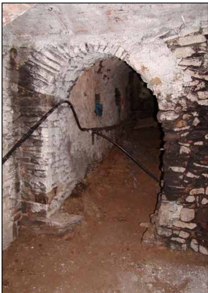
Foto č. 8 - Klenutý východ z barokního do chodbicového sklepení
