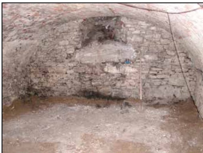
Foto č. 42 Barokní sklepení - pohled na čelo s okenním záklenkem vedoucím na náměstí
