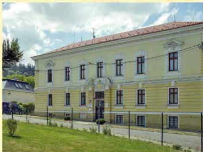
Dům č. p. 435. Foto: Jindra Kunc
