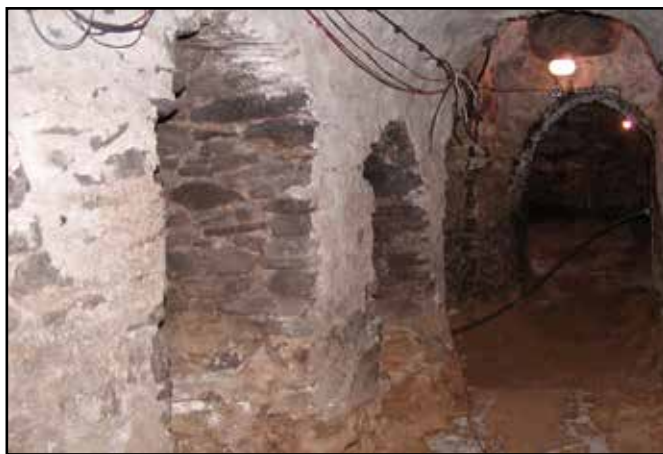
Foto č. 5 - Zaklenuté výklenky chodbicového sklepa - pohled od vstupu do sklepa
