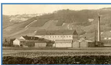
Pohled na bývalou továrnu od východu. Archiv společnosti Mateiciuc, a. s.
