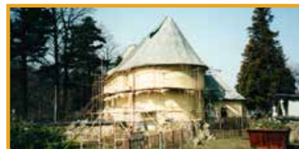
Heřmánky, 2003. Probíhající oprava kostela Neposkvrněného početí Panny Marie.
