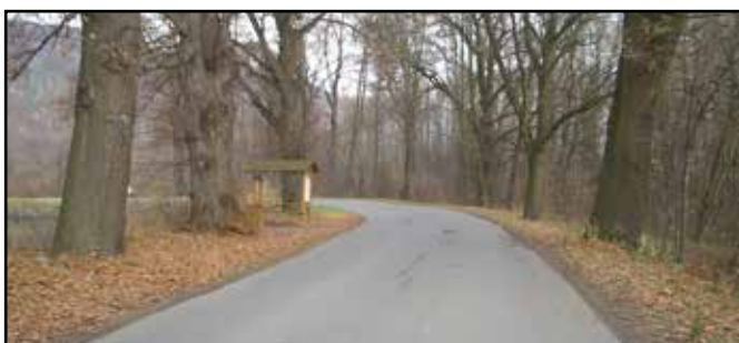
Silnice z Vražného do Oder, vedená po hrázi Emauzského rybníka. Na levé straně silnice je odpočívadlo, postavené proti bývalému hostinci Tiergartenhaus.
