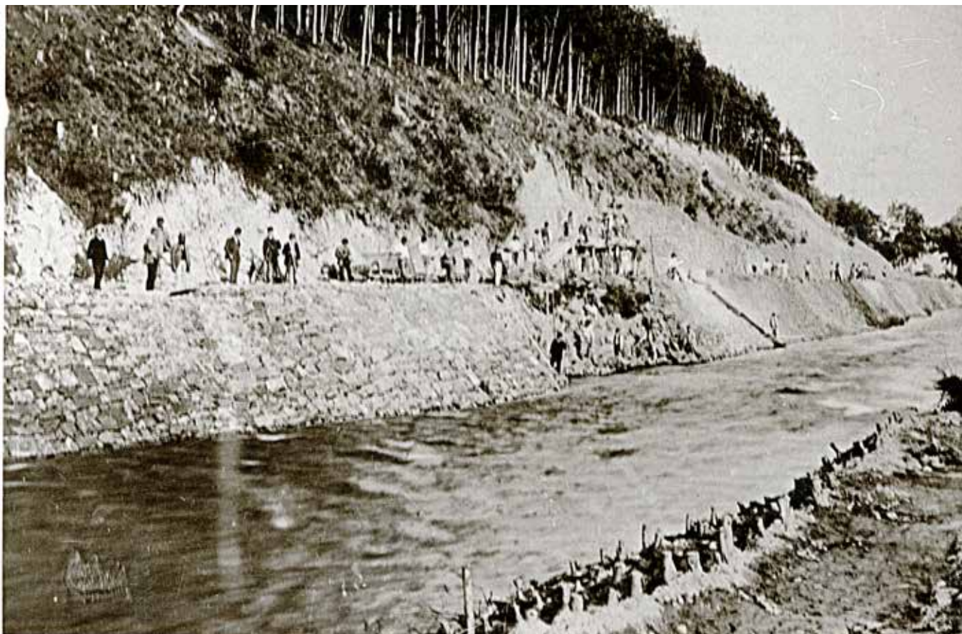
Stavba železniční trati Suchdol n. O. - Budišov n. B. u mankovického mostu, 1891. Archiv muzejního spolku Rolleder, o. p. s.
