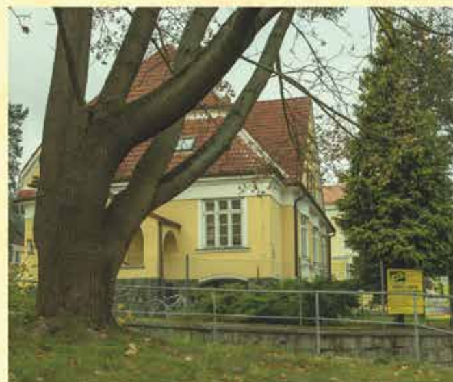
Dům č. p. 516. Foto: Jindra Kunc
