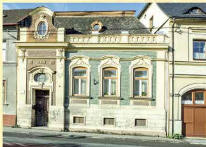
Dům č. p. 239. Foto: Jindra Kunc
