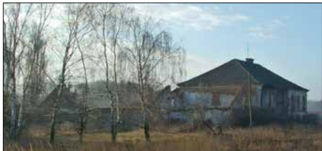
Chátrající objekt bývalé hynčické rychty - foto: Jiří Kucharz
