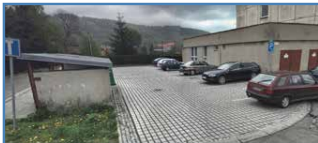
Oprava parkovací plochy u ubytovny
