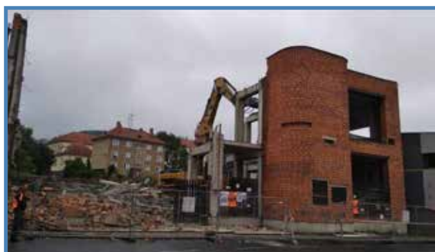
Demolice rozestavěného kina
