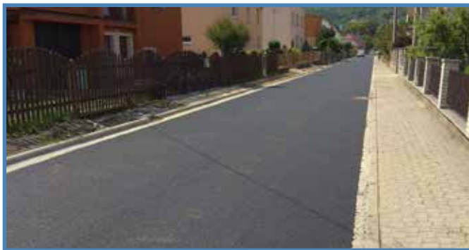
Oprava komunikace ul. Fučíkova
