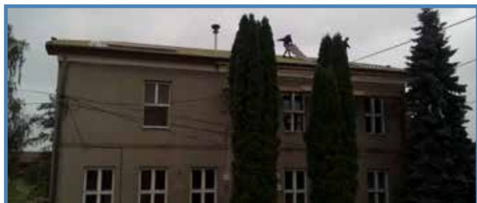
MŠ Kamenka – oprava střechy
