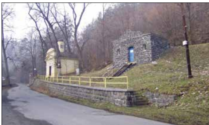
Kamenný vodojem a kaple Panny Marie. Foto: Petr Lelek
