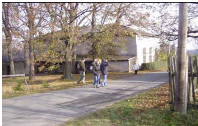
Dvořisko, usedlost č. p. 81 s bývalým výletním hostincem. Foto: Petr Lelek
