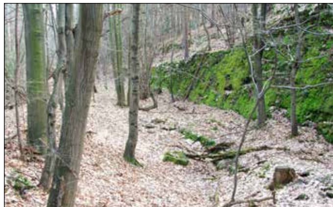
Nedokončený skalní zářez mezi Děrným a Lukavcem.
