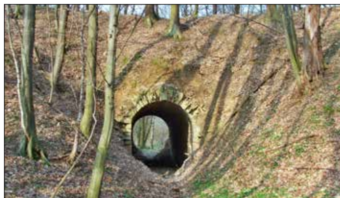
Propustek levobřežního přítoku Gručovky pod Děrným.
