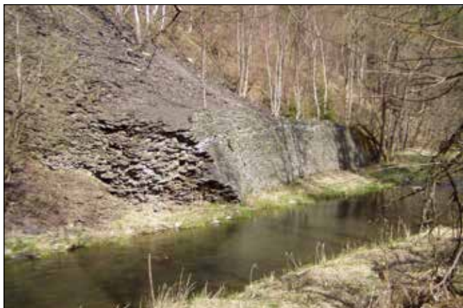
Úpatní kamenná zeď zamezující sesutí odpadní břídlíce do řeky Odry.
