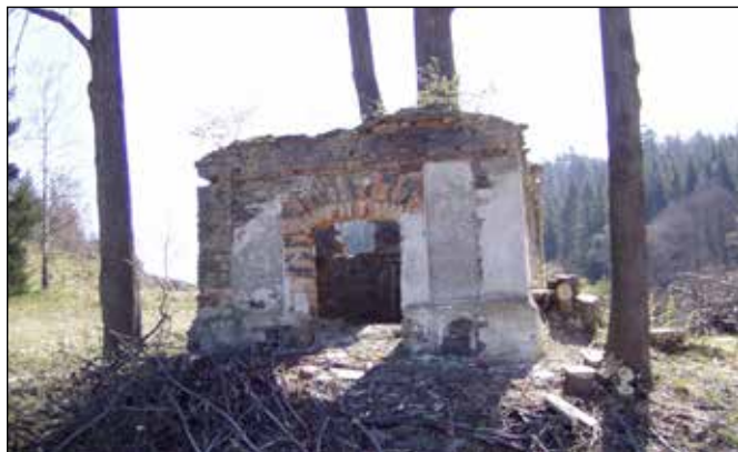
Kaplička mezi Rudoltovicemi a Vojnovicemi před obnovou.
