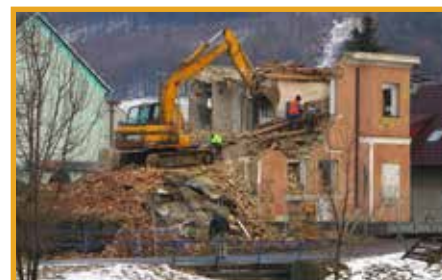
Demolice domu v roce 2017
