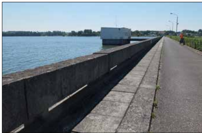
Hráz přehrady „Jezioro Rybnickie” zřízené na řídce Rudě.
