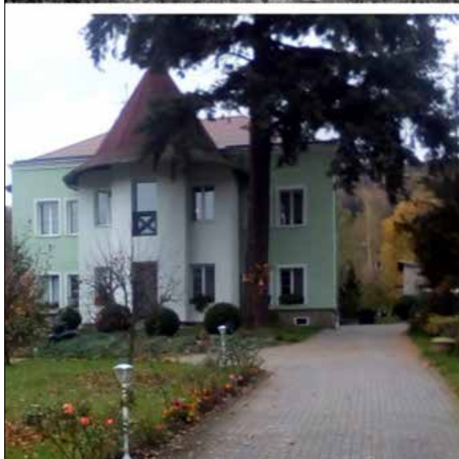
Odry, Hranická č. p. 410, 1910, pohled na vilu stavitele Eduarda Blaschkeho - Muzejní spolek Rolleder, 2017 foto autor. Pohled na dům seniorů.
