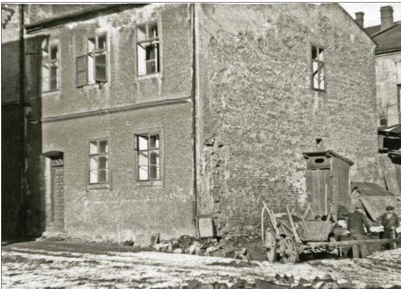
Odry, Radniční ulice № 128 - dobová fotografie. Sídlo rodiny Kobielových po roku 1918. Muzejní spolek Rolleder
